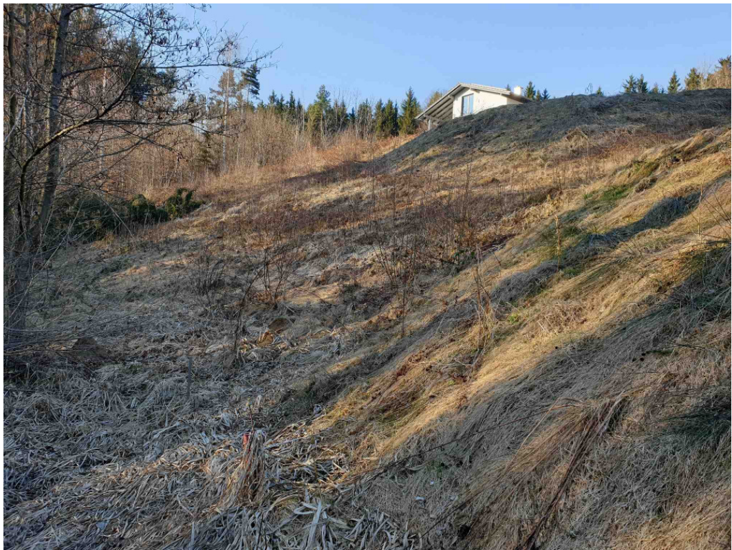
Abb.1 Blick von Standort an der Süd-Ost-Ecke des Geltungsbereichs
