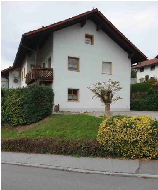
Abb. 5 Wandhöhe Flur-Nr. 321/53, 3-geschossig, südlich angrenzend
