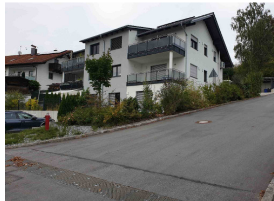
Abb. 4 Wandhöhe Flur-Nr. 321/6, 3-geschossig, nord-östlich angrenzend,
