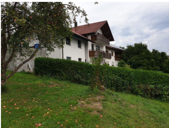
Abb. 3 Wandhöhe Flur-Nr. 321/15, 3-geschossig, östlich angrenzend
