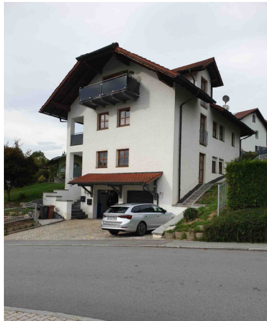
Abb. 6 Wandhöhe Flur-Nr. 321/17, 4-geschossig, südlich angrenzend
