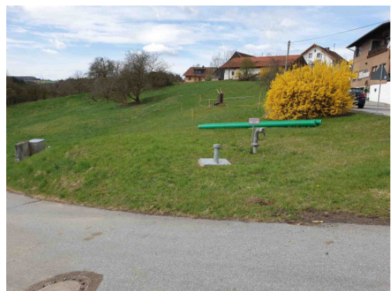
Abb. 2 Blick von Osten, Löschwasserbehälter
